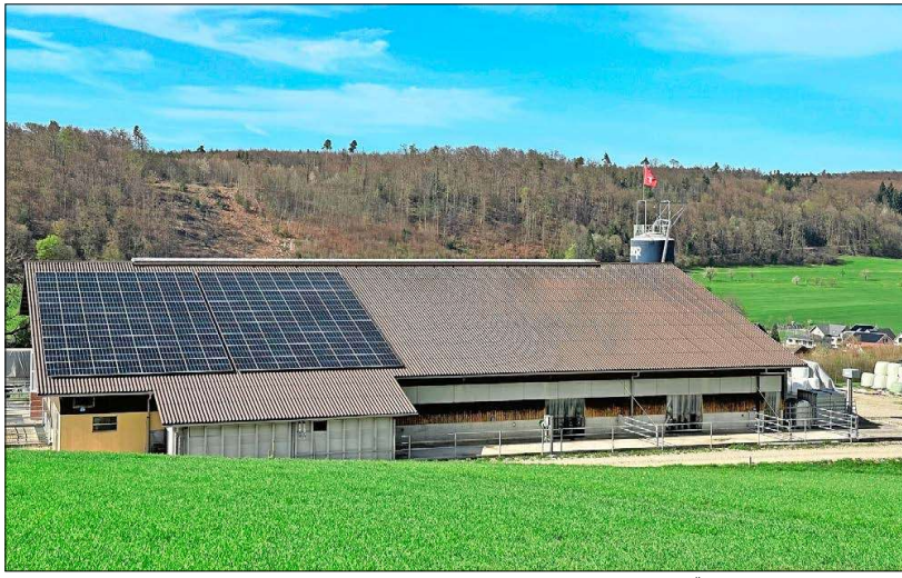
PV-Anlagen auf Bauernhöfen sind möglichst auf den Eigenverbrauch auszurichten. Oder der Überschussstrom kann wirtschaftlich selbst vermarktet werden. Das Bild zeigt eine Anlage bei Hersberg BL. (Bild Josef Scherer)
